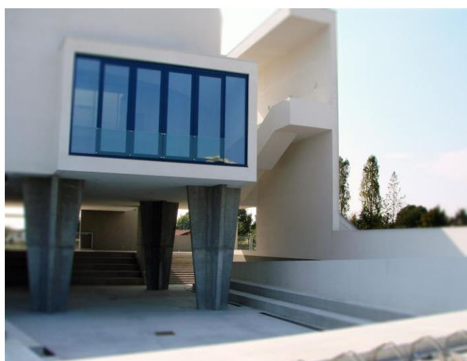
Edificio di via Sansovino, 6/a: il teatro all'aperto
