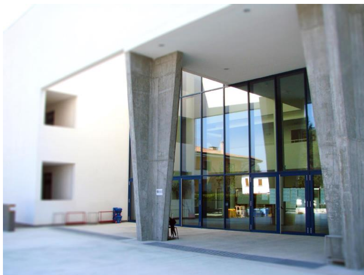
Edificio di via Sansovino, 6/a: l'ingresso nord
